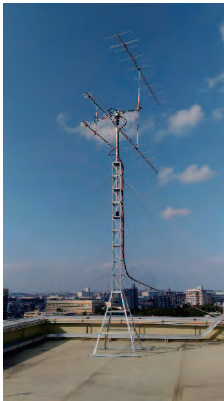
第二地上局用 UHF/VHF アンテナタワー
